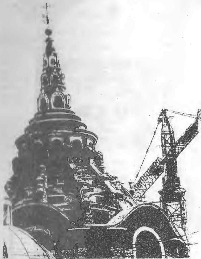
Particolare della cupola della Cappella della Sindone durante un periodo di restauri alla medesima
